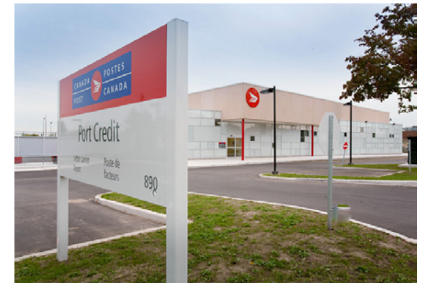
Postes Canada a 32 projets d'immeubles certifiés LEED à l'échelle nationale, y compris ce poste de facteurs à Port Credit, en Ontario.
